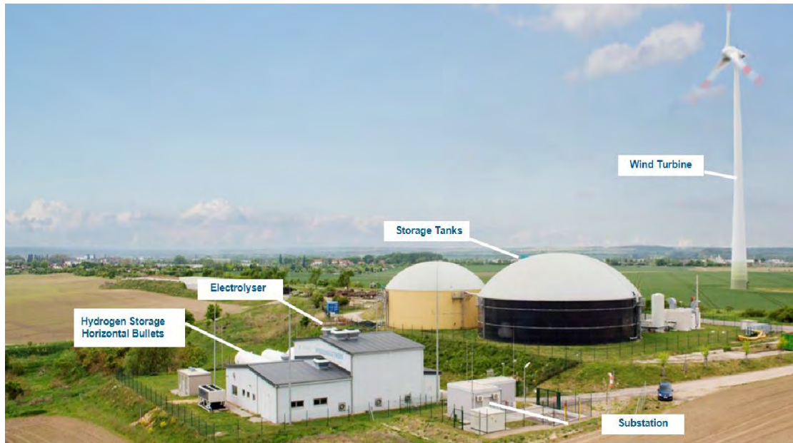
Figure 1-6: ENERTRAG Germany's Hybridkraftwerk
